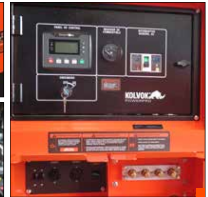
Completo Panel de Control Multifunción Dos enchufes hembra 230V/30ª Bornera trifásica Factibilidad de conexión ATS
